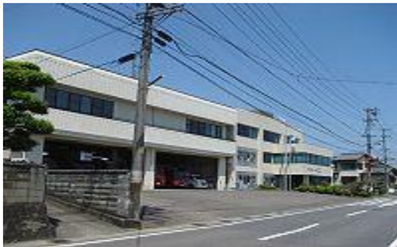
可茂消防事務組合消防本部
